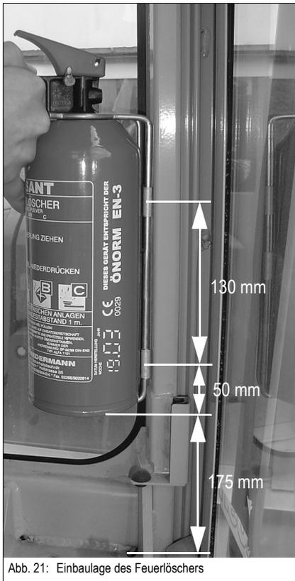
Abb. 21: Einbaulage des Feuerlöschers
